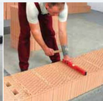
rys. 9. Wyrównanie pustaków w pierwszej warstwie w kierunku poprzecznym
