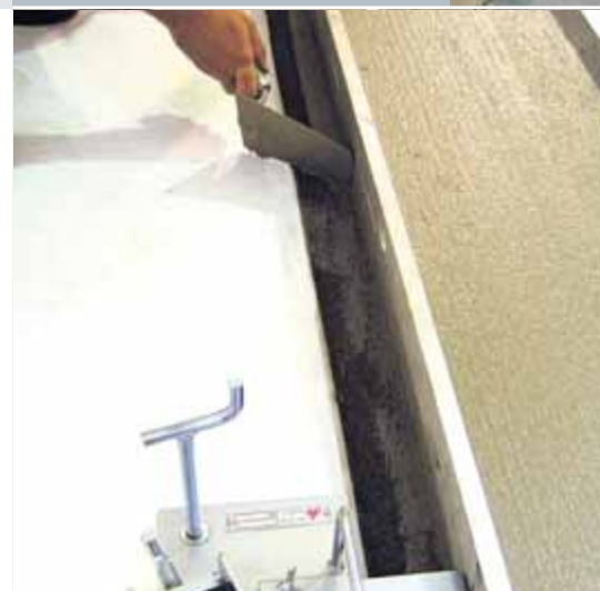
rys. 5. Usunięcie nadmiaru zaprawy.
