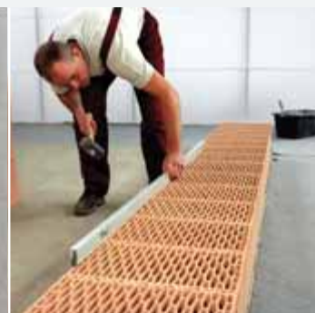
rys. 8. Wyrównanie pustaków w pierwszej warstwie wzdłuż ściany
