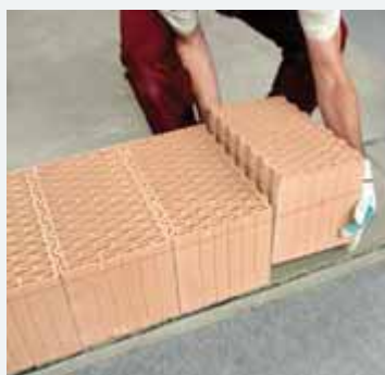
rys. 6. Układanie pierwszej warstwy pustaków
