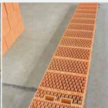
rys. 7. Ułożona pierwsza warstwa muru obwodowego
